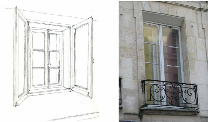
Exemple de doubles-fenêtres, vues de l'intérieur et de l'extérieur, source : ATHEBA
