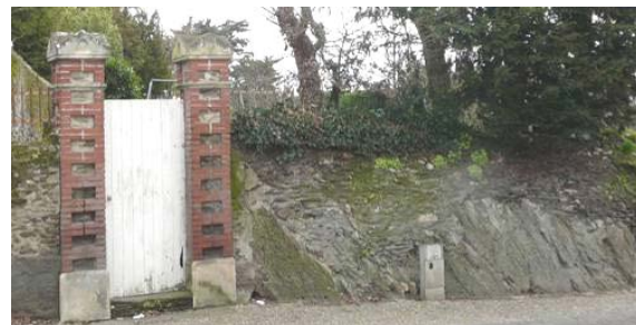
Mur de clôture bâti sur un soutènement de schiste affleurant
