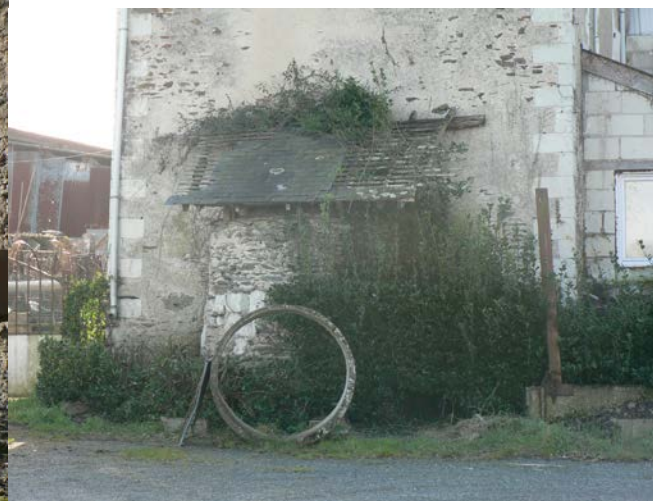
Ancien four attaché à l'habitation principal
