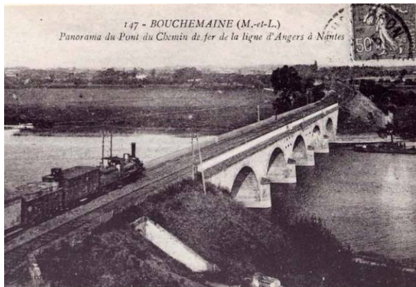
Pont d'Orléans, 1846-50 Pont de chemin de fer de la ligne Tours - Nantes, premier pont construit sur la commune de Bouchemaine
