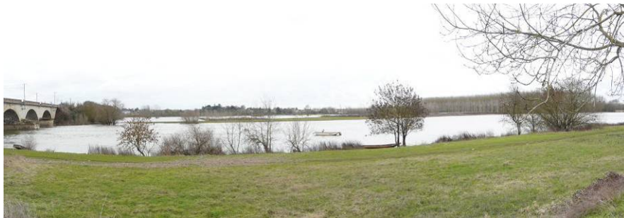
La Maine au niveau du pont ferroviaire
