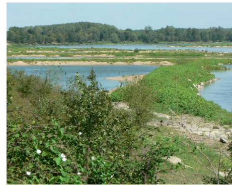
Enrochements au droit de la pierre Bécherelle
