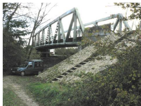
Ponts, digues, empièvements
