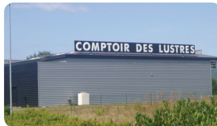
Enseigne en toiture illégale (lettres non découpées) - Beaucouzé
