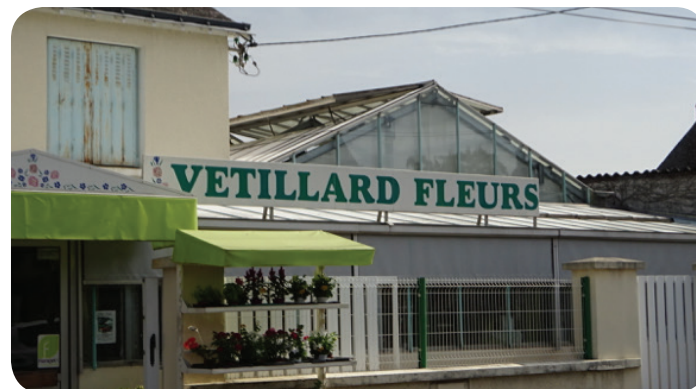
Enseigne en toiture illégale - Angers
