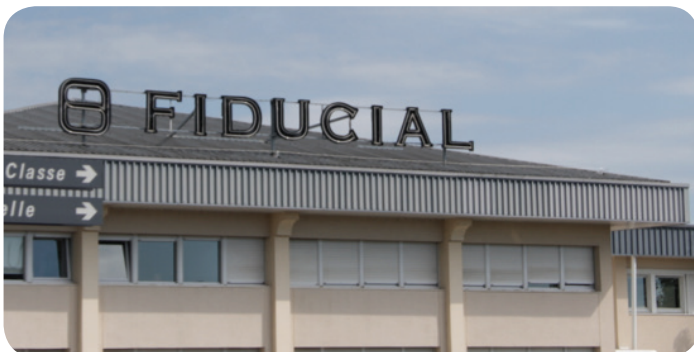
Enseigne non-conforme - Les Ponts-de-Cé
